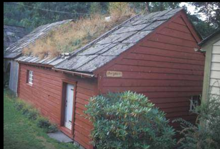
Kombinasjon av torvtak og helletekking, Borgstova på Vikøy prestegård, Hardanger
