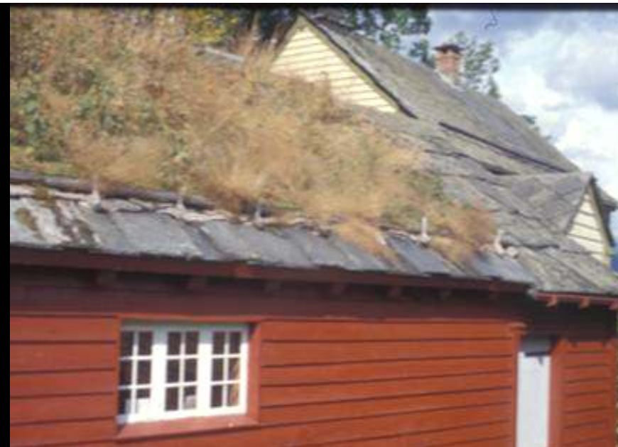
Kombinasjon av torvtak og helletekking, Borgstova på Vikøy prestegård, Hardanger
