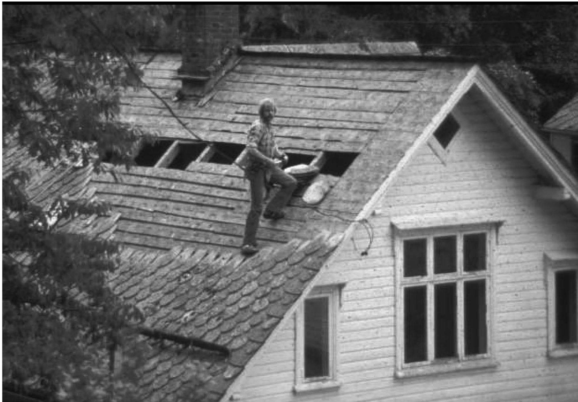
Lappskifer ble tidligere spikret rett i sutaket, på oppforede lekter først etter krigen
