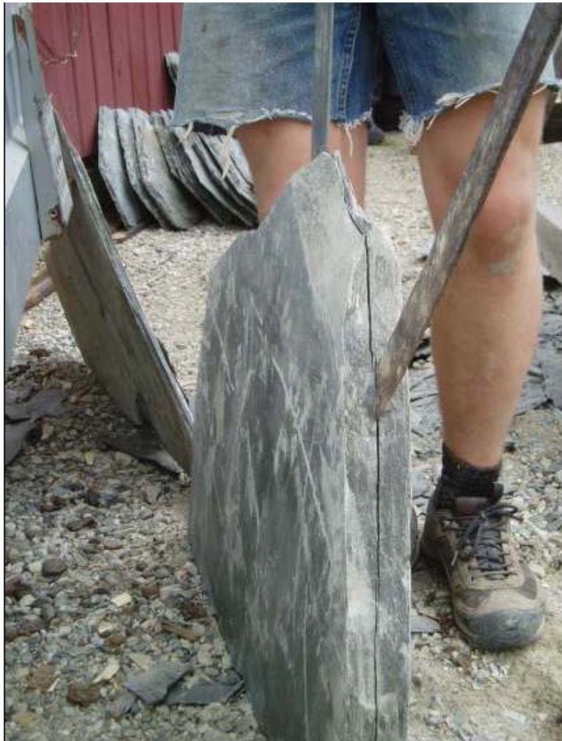
Kløyving og skanting av heller, uthusprosjektet på Røros
