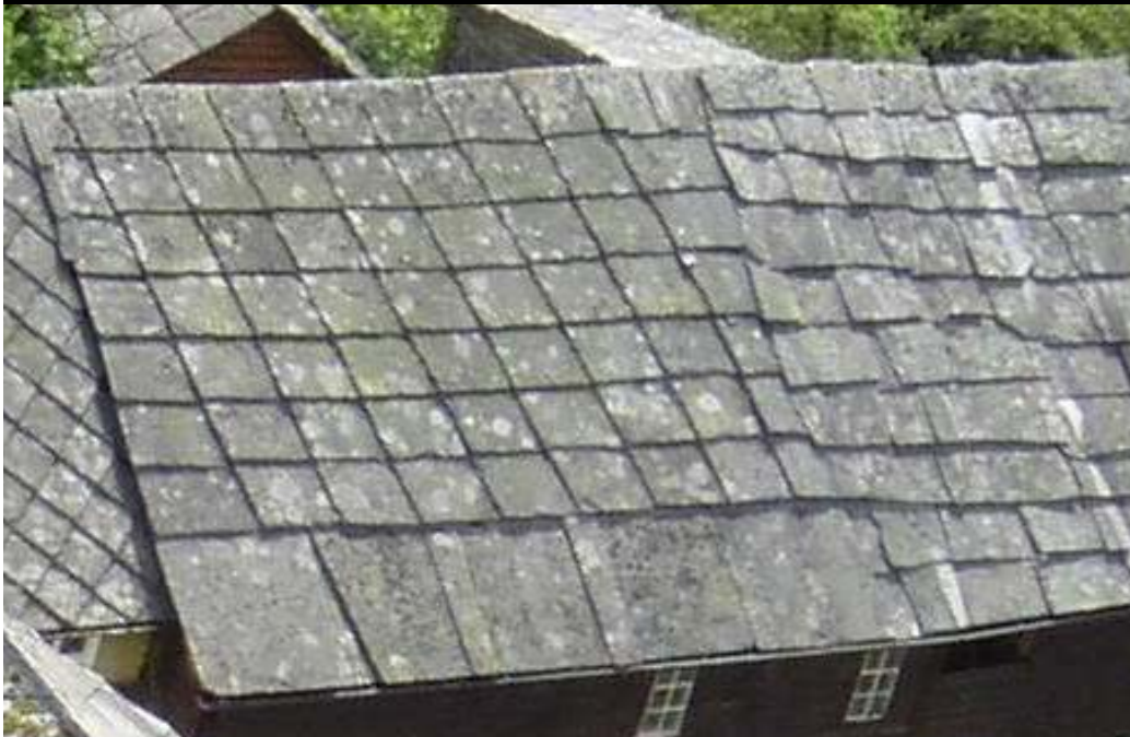
"sidesua" rasteheller, Nedrevåge på Tysnes og lagmannsstova i Agatunet
